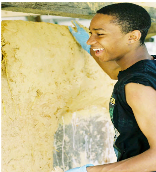
Fig. 27. Applying lime
