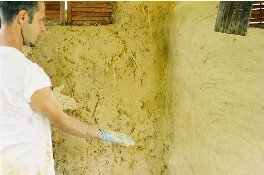
Fig. 28. Scratch coat: Final coat
