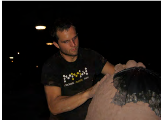
Fig. 30. Cob layers
